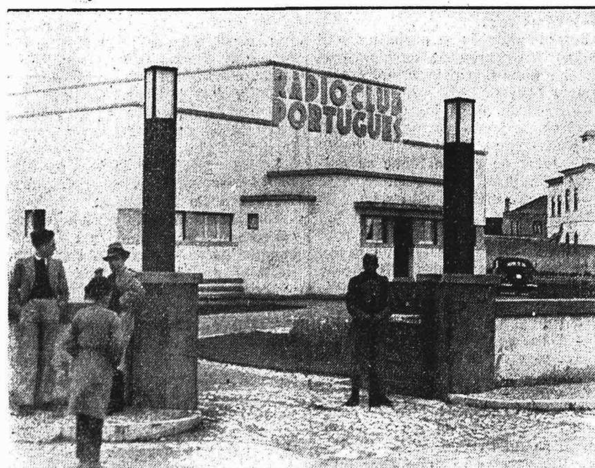
Le bâtiment du Radio-club de Lisbonne a été, comme on le sait, atteint par une bombe. Depuis, l'édifice est surveillé militairement
